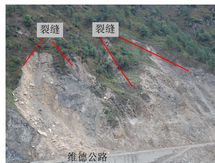
图 14 K194+440~K194+820 处特大型滑坡
